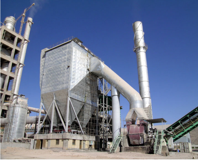
غبارگیر از نوع الکتروفیلتر به همراه فن و دودکش
